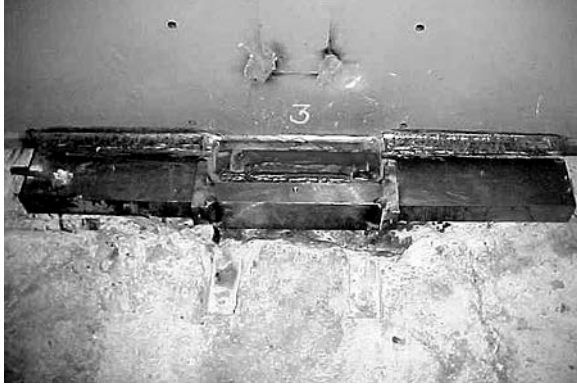
Figura 3 Modificación de la plancha de anclaje y guía de un estator Westinghouse.
