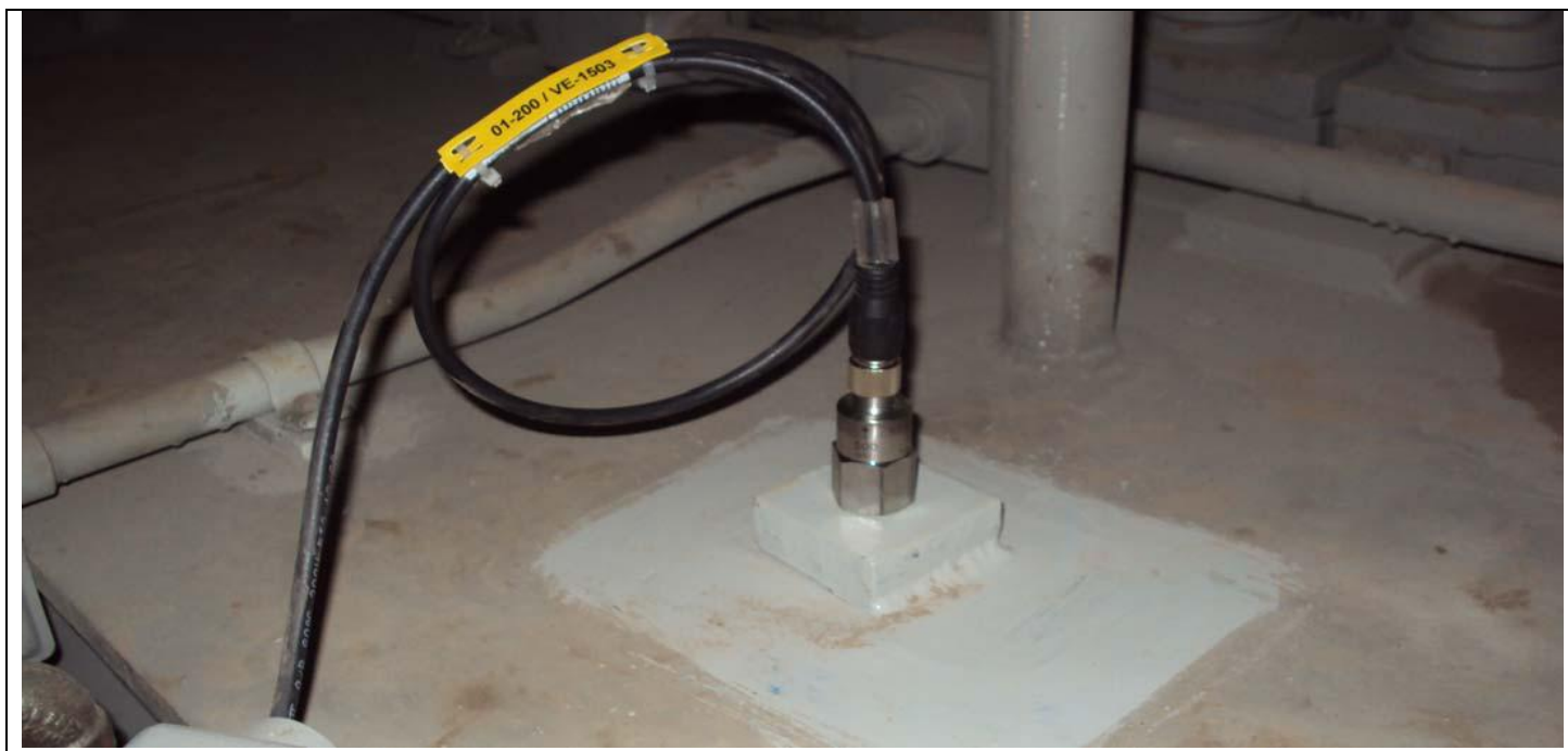
Figura 1: Instalación Típica de la Cadena de Medición VSM797S.
