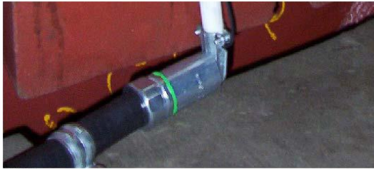
Figura 26: Conducto flexible conectado al ensamble del codo.
