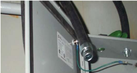
E101208G Figura 24: Conexión del conducto flexible a la caja de
