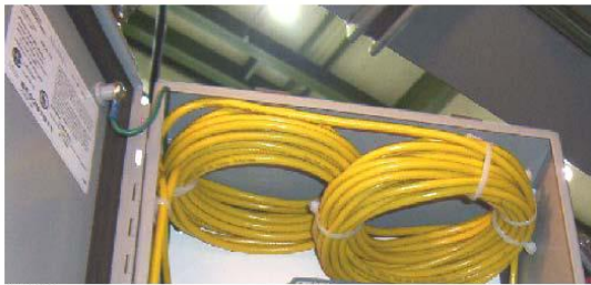
Figura 27: Exceso de cable almacenado en la caja de protección.
