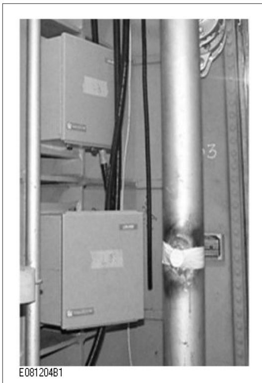
Figura 42: Ubicación adecuada para una caja de protección.
