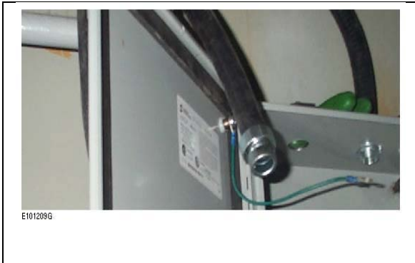
Figura 24: Conexión del conducto flexible a la caja de protección
