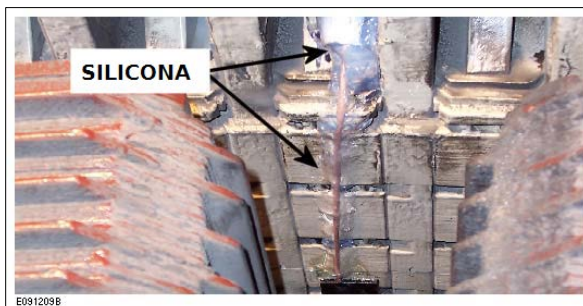
Figura 23: Aplicación de silicona.
