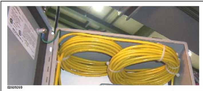
Figura 22 : Exceso de cable guardado en el receptáculo
