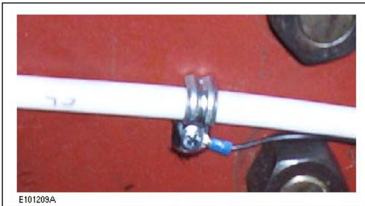
Figura 17 : Sujetando el alambre de conexión a tierra a la estructura usando una abrazadera para cable
