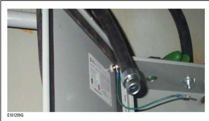
Figura 19 : Conexión del conducto flexible al receptáculo
