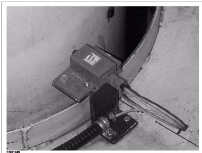
Figura 55 : Instalación completa de la sonda de sincronización
