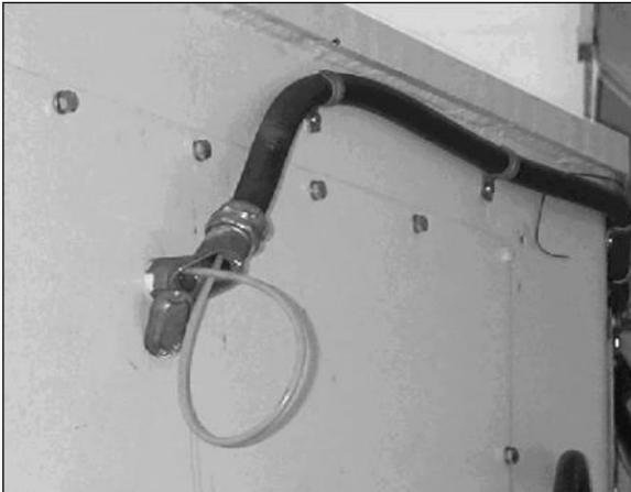
Figura 13: Introducción de un cable dentro de un conducto flexible.
