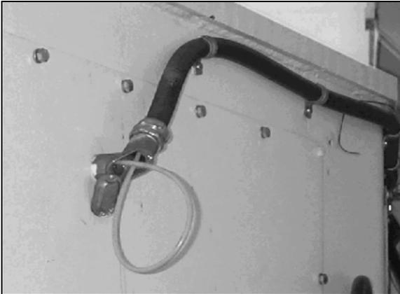
1. Determine por donde va a colocar el conducto de protección desde la caja de protección hasta la ubicación del gabinete de instrumentación. Desenrolle el conducto flexible siguiendo el curso planeado del cable. Corte el conducto a la longitud deseada. Debe usar abrazaderas en los cables para asegurarlos a los conductos protectores.
