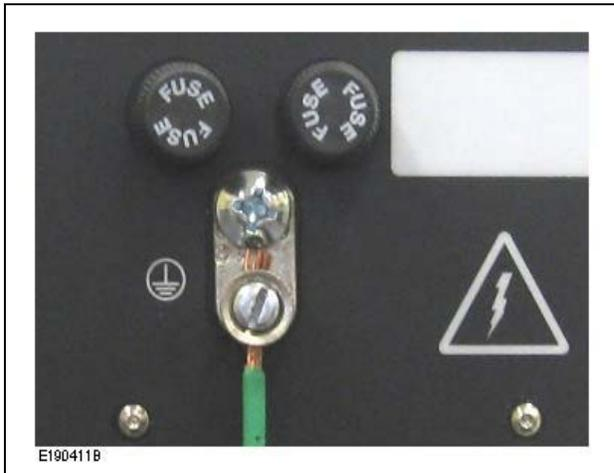
La terminal de conductor protector debe estar conectada a un punto de aterrizamiento de acuerdo a regulaciones locales. El aterrizamiento es esencial para propósitos de seguridad, así como para suministrar una mejor eficiencia contra las perturbaciones ESD y EMI.
