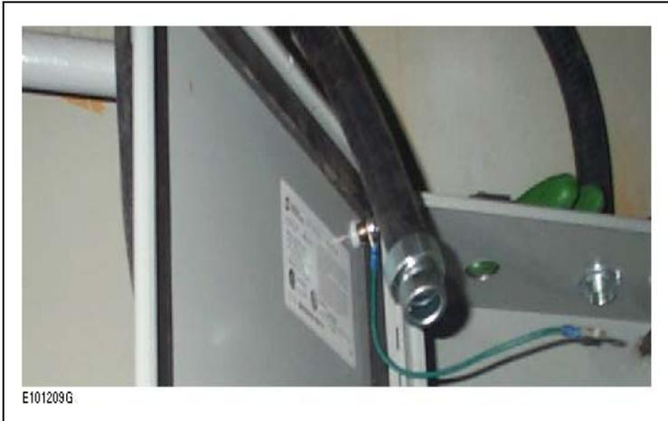
Figure 17 : Raccordement du conduit flexible à un boîtier de protection
