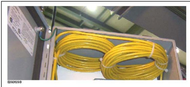
Figure 20 : Surplus de câble entreposé dans un boîtier de protection
